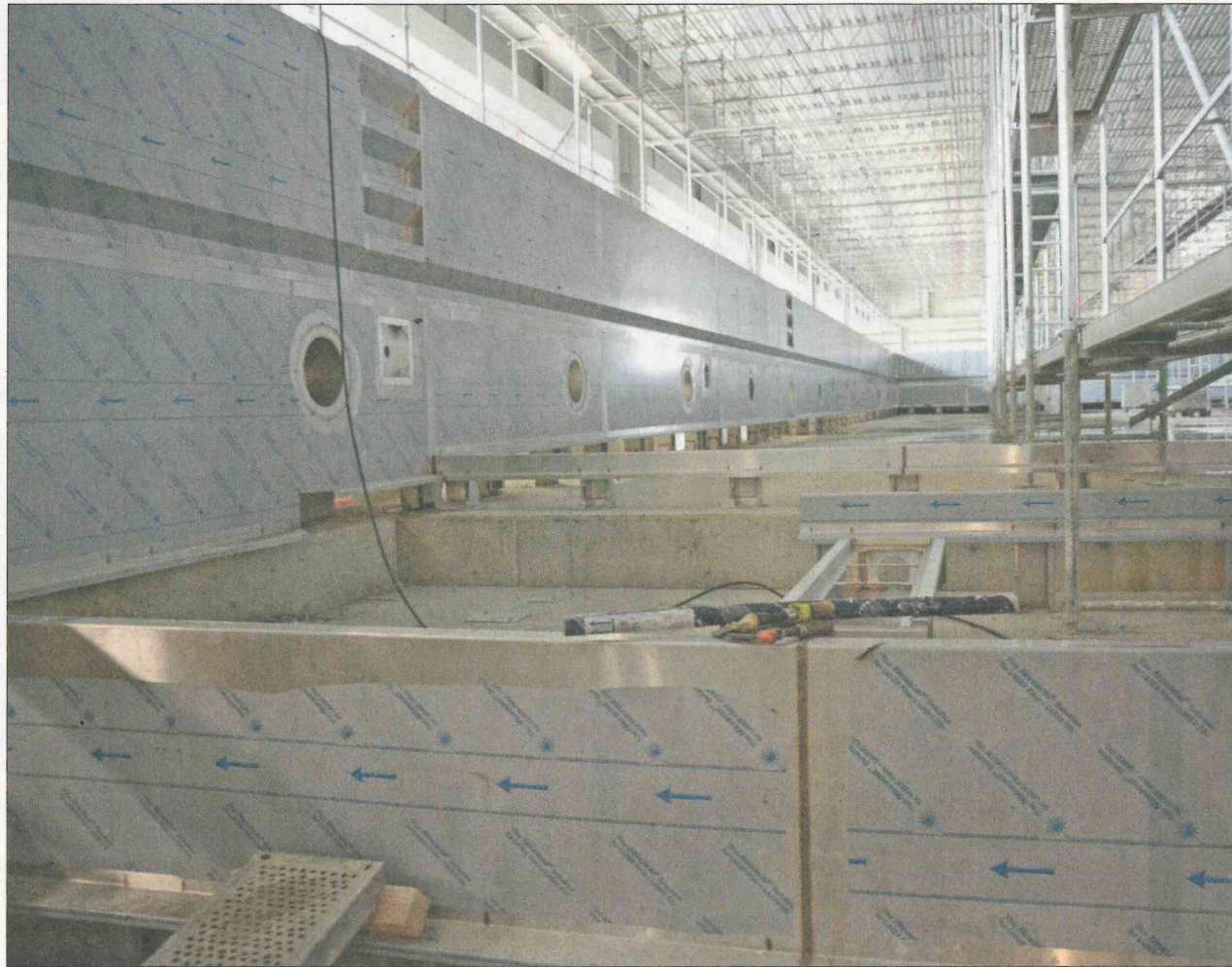
Die Seitenwände des neuen Olympia-Beckens im Campus Sursee hat die Surseer Firma Mauchle Pool bereits montiert. Bis im September sollen alle Arbeiten innerhalb des Beckens fertig sein. FOTO THOMAS STILLHART
