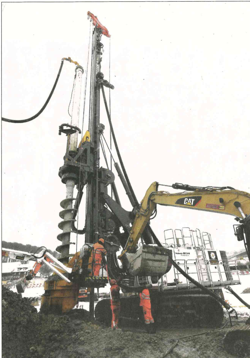
Mit dieser Maschine hat das Bauunternehmen Implenía erstmals in der Schweiz Pfählungen im Campus Sursee vorgenommen.
